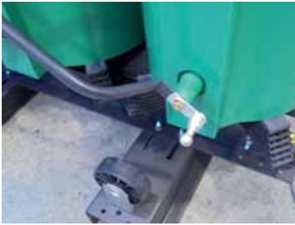
*Anschlüsse OS-Wicklung mit Kugelanschlussbolzen*
